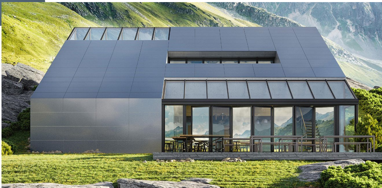
Gebäudeintegrierte Photovoltaik im minimalistischen Design Besucherzentrum mit Restaurant mit BIPV-Dach und -Fassade.
